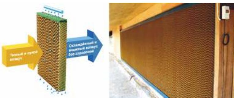
Принцип работы и пример кассет охлаждения
