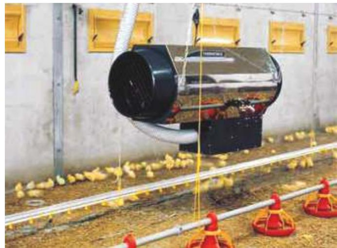
Зачастую используется совместная схема обогрева птичников. В таких случаях брудеры используются как первичный источник тепла. Нагреватели объема обеспечивают дополнительный обогрев в период холодной погоды, а также используются при подготовке птичника к посадке. С возрастом птица развивает способность регулировать температуру тела и после 14 дней нагреватели объема становятся основным источником тепла.
