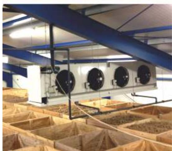
Стандартный комплект оборудования для овощехранилища состоит из 3 основных узлов: воздухоохладитель, конденсатор, компрессор.
